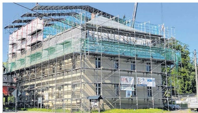
Derzeit wird am Rittergut Bösenbrunn das Mansarddach saniert. Das Bild entstand am 13. Juni beim Abbau des großen Schutzdaches nach sieben Monaten.
